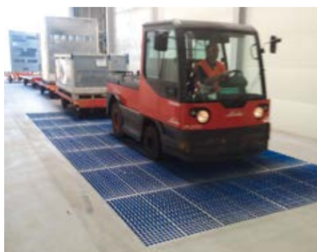
Tren remolcador de material desde el exterior
